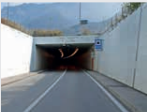
E Lütchinen- unterführung
