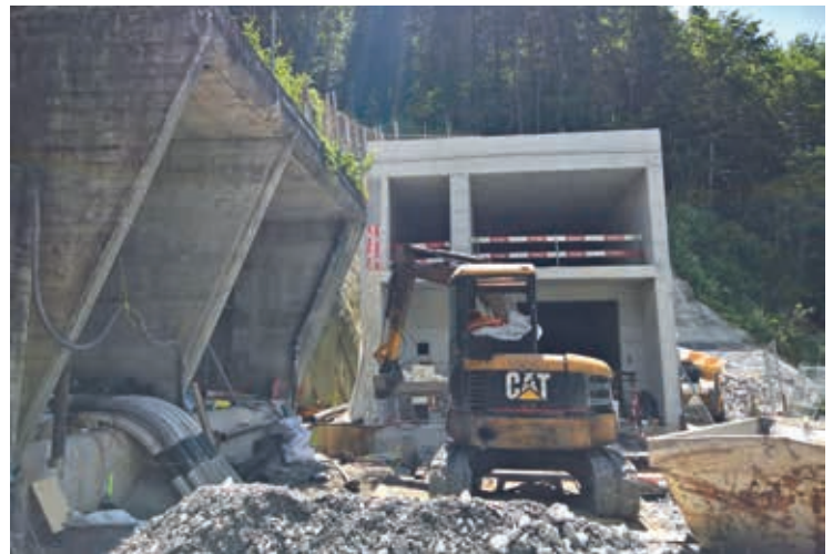
Letzte Umgebungsarbeiten vor dem Ostportal
