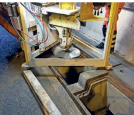
Die Abdeckungen werden mittelsamt Rahmen komplett ersetzt.
