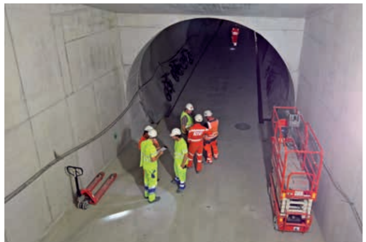
Auch das westliche Portal des Giessbach-Sicherheitsstollens ist im Rohbau fertig.
