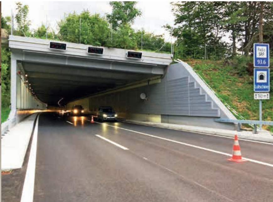
In der Lüttschinenunterführung werden noch bis im Herbst nächtliche Installationsarbeiten ausgeführt.
