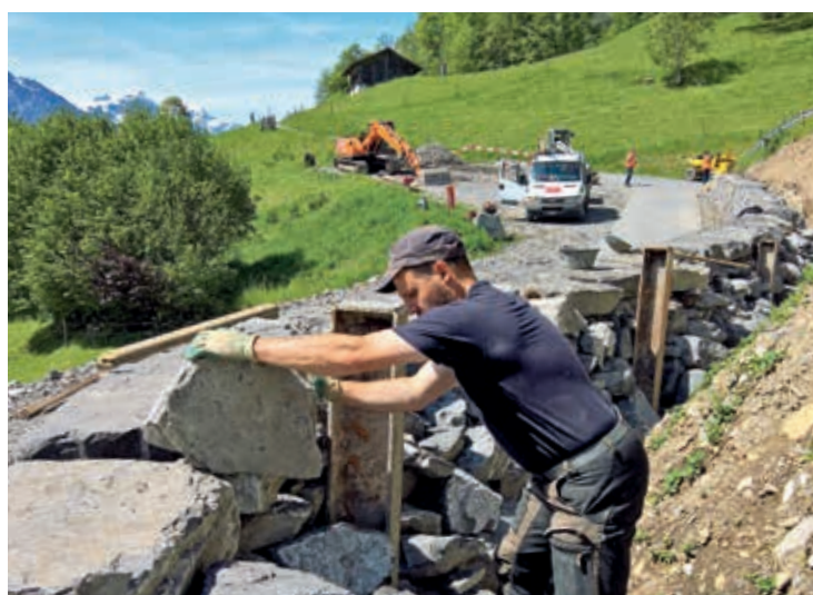
Das Bauen von Trockenmauern erfordert viel Handarbeit.
