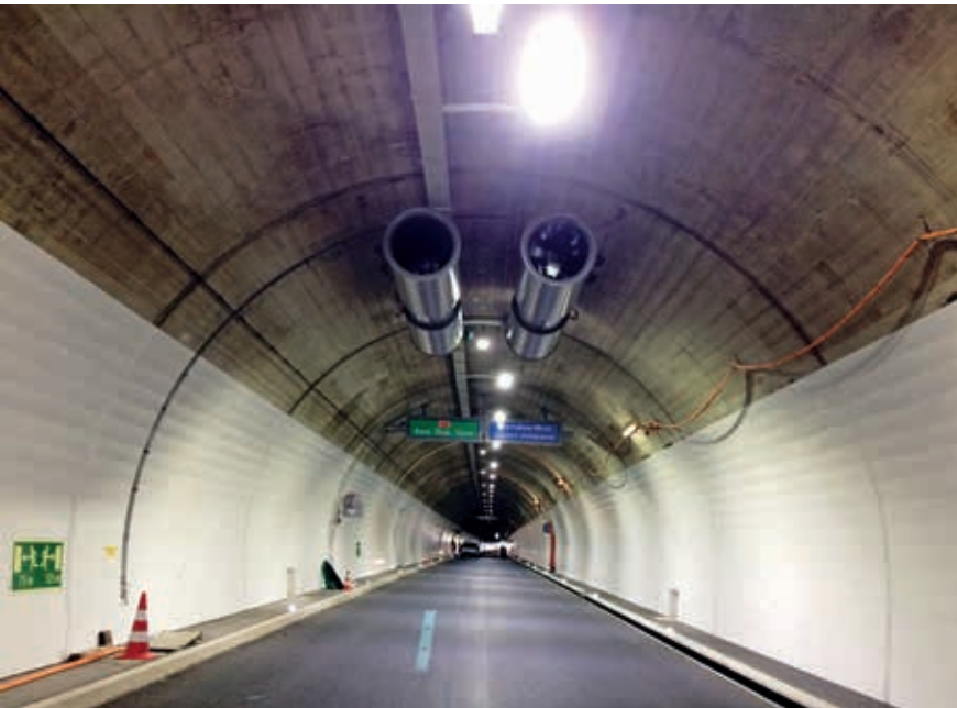
Neue Elektrotechnik: In der Nordröhre des Rugentunnels sind schon viele neue Elemente montiert.
