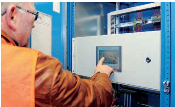
Komplex und robust: Die Steuerung koordiniert sämtliche Funktionen des Sengg-Fluchtstollens.
