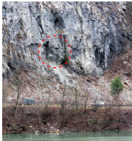
Blick von Süden zum Standort des künftigen Stollenportals; der historische Militärbunker (rot eingekreist) ist gut getarnt. Das Fluchtstollen-Portal entsteht direkt darunter an der Kantonsstrasse.
