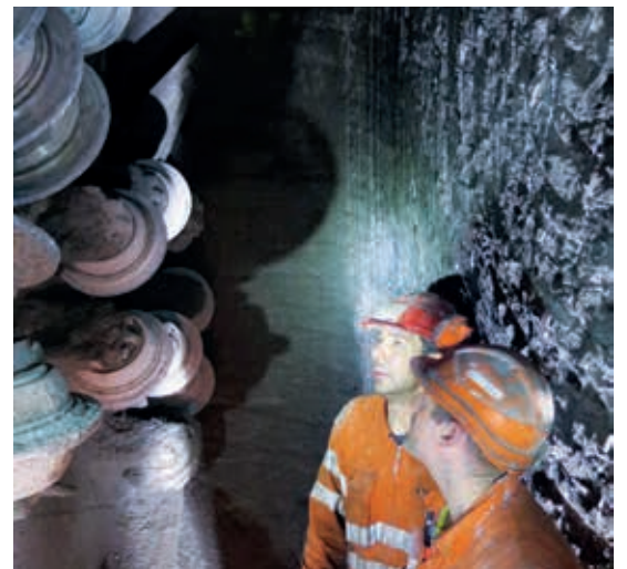
Zwischen Bohrkopf und Tunnelwand: Zwei Mineure begutachten den Verschleiss der Bohrmeissel.
