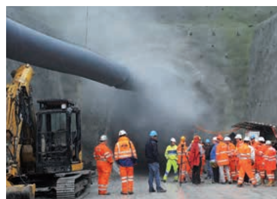
Mit einer Sprengung wurden die Bauarbeiten beim Ostportal des Chüebalm-Rettungsstollens offiziell aufgenommen.
