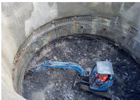
Auch beim Fluchtstollen für den Senggtunnel sind die Arbeiten in vollem Gang. Das Bild zeigt den Ausbruch des senkrechten Schachts.
