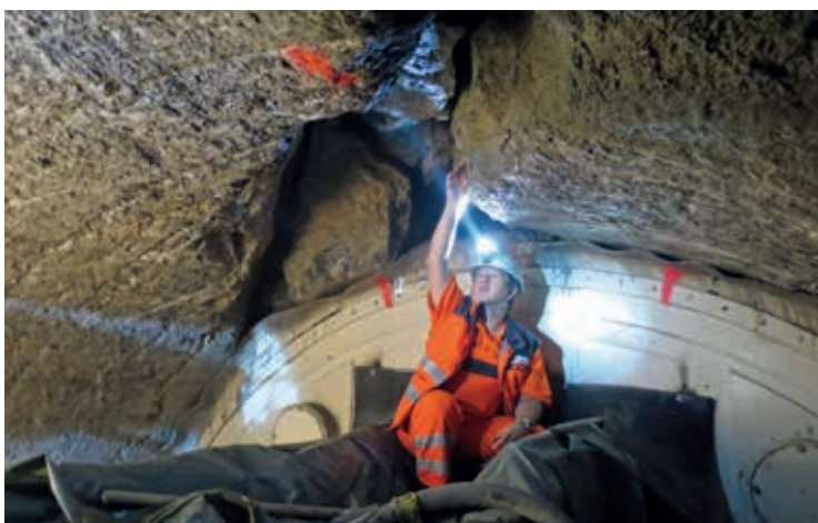
Walter von Weissenfluh begutachtet beim Bohrkopf der Tunnelbohrmaschine eine Kluft im Gestein.
