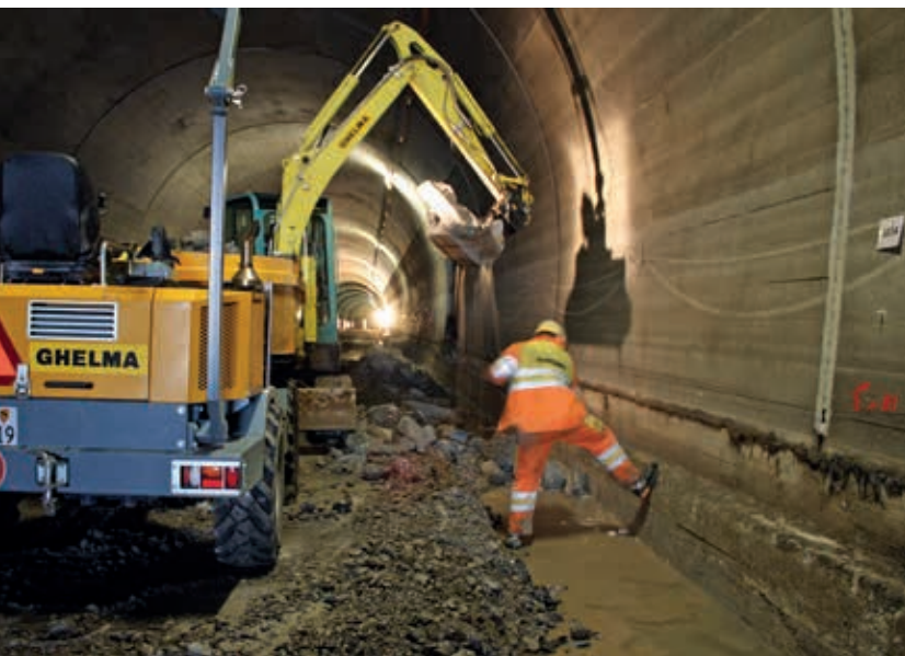
Arbeiten in der aktuell gesperrten Südröhre des Rugentunnels
