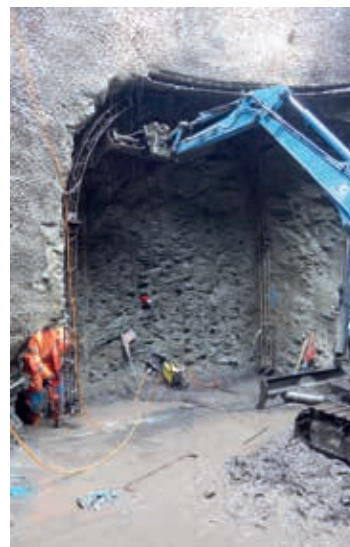
Beginn der Bauarbeiten für die Quer-Verbindung zwischen dem Schacht und dem Senggtunnel
