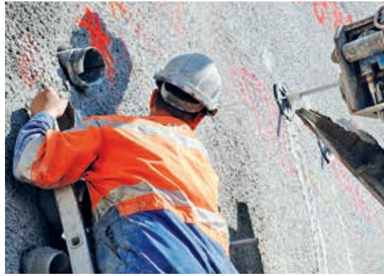
Die ersten Meter des Sicherheitsstollens beim Giessbachtunnel verlaufen durch Lockergestein. Die entsprechende Strecke muss daher mit einem Rohrschirm gesichert werden.
