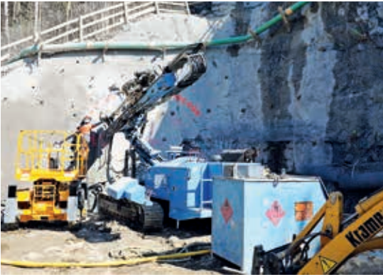
Die ersten Meter des Sicherheitsstollens beim Giessbachtunnel verlaufen durch Lockergestein. Die entsprechende Strecke muss daher mit einem Rohrschirm gesichert werden.
