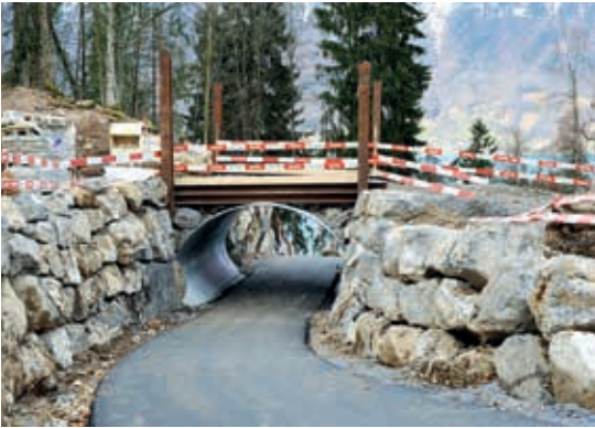
Die Veloroute Giessbach–Iseltwald unterquert die Baupiste östlich des Chüebalmtunnels mittels einer provisorischen Unterführung.
