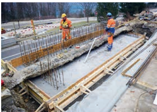
Die Fundamente der Bauhilfsbrücke beim Rastplatz Glooten wurden Ende Januar betoniert.
