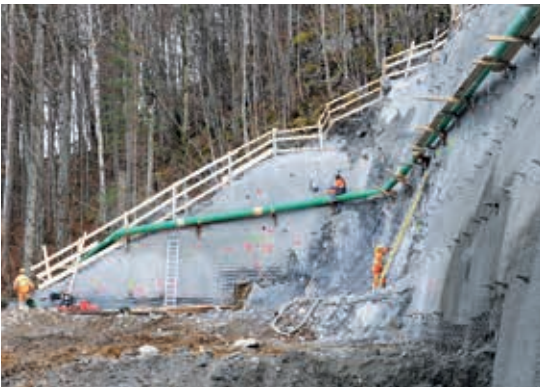
Der Voreinschnitt beim künftigen Westportal des Giessbach-Sicherheitsstollens.
